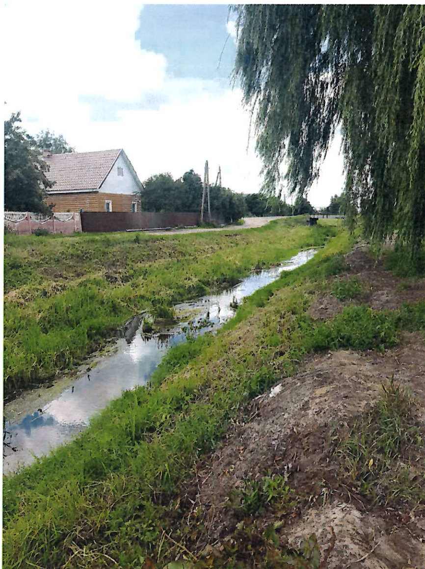
Рисунок 5 – Мелиоративный канал в районе реконструируемого коллектора
